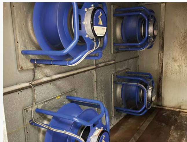
Ugradnja EC ventilatora
