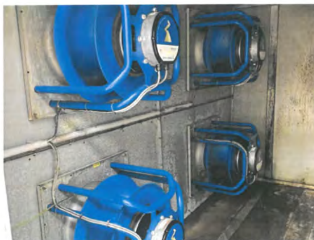
Ugradnja EC ventilatora
